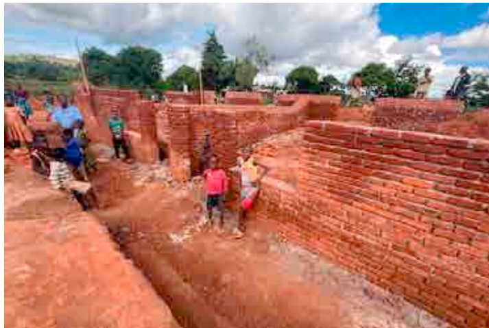
An den 6 Baustellen arbeiten insgesamt 155 Bauarbeiter
